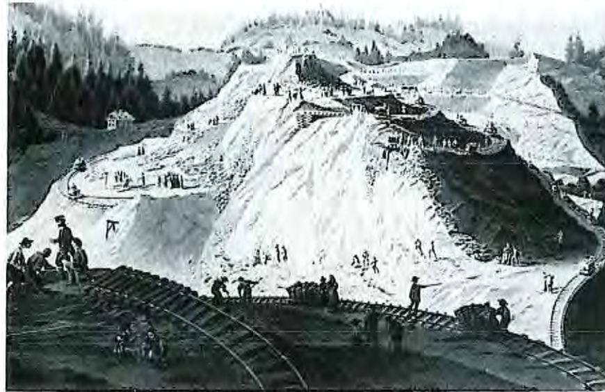
Eisenbahndamm Harbatshofen: Mit 525 m Länge und 53 m Höhe der damals größte Damm Europas
