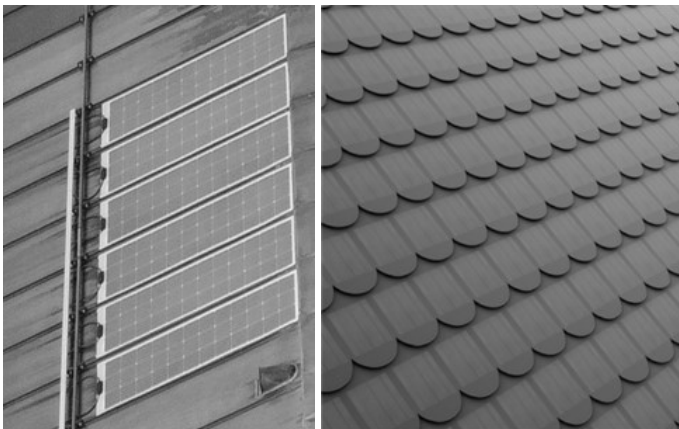
Beispiele: Flache, flexible Module auf Blechdach (links); Solarziegel der Firma solteq.de (rechts)
